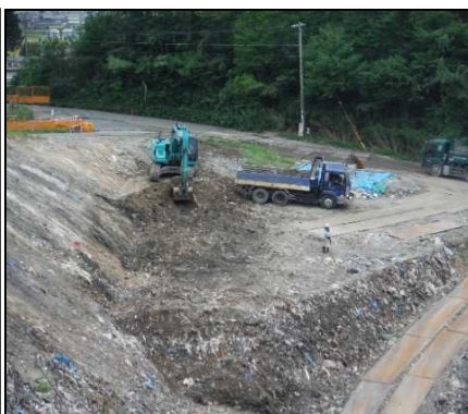
①-1 D・E工区廃棄物土掘削工 E工区廃棄物土を掘削しています。
