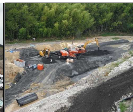
⑥ 底面・側面遮水工 CD工区側面遮水工を行っています。
