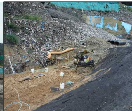
⑥ 底面・側面遮水工 D工区追加ボーリング調査を行っています。
