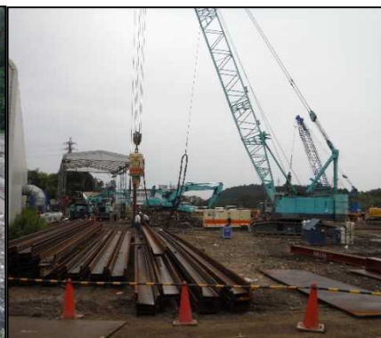
② 有害物掘削工
