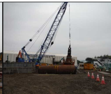
② 有害物掘削工
