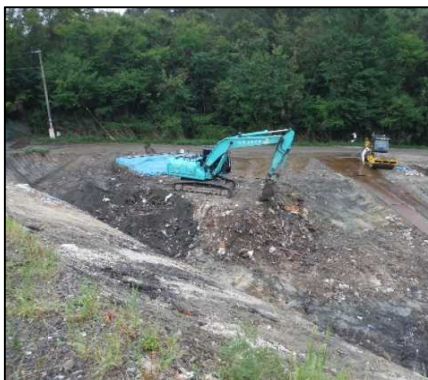
①-1 D・E区廃棄物土掘削工
