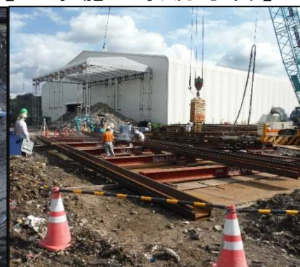
② 有害物掘削工 C区画の鋼矢板を溶接して接続しています。右手に見えるのは鋼矢板打設です。
