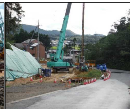
③ 伐開工 I区画の鋼矢板を圧入しています。
