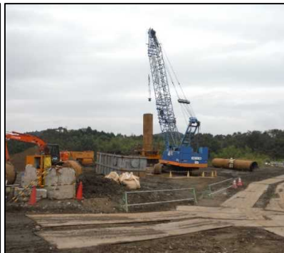
② 有害物掘削工 FG区画の置換杭を掘削しています。
