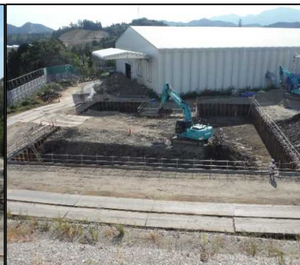
② 有害物掘削工 C区画の廃棄物土を掘削しています。
