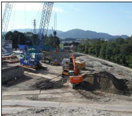
② 有害物掘削工 掘削終了後砂で埋戻しを行っています。
