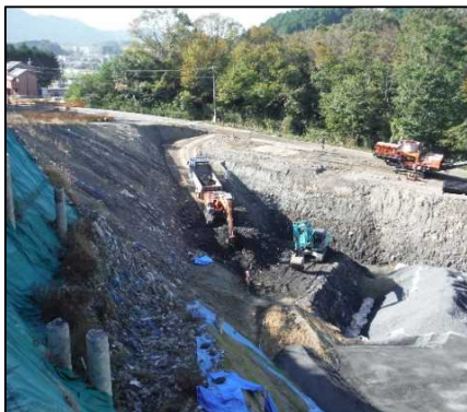
① 廃棄物掘削工 E工区の掘削を行っています。
