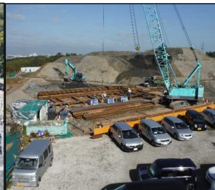
② 有害物掘削工 FG区画の鋼矢板を溶接して所定の長さにはしています。
