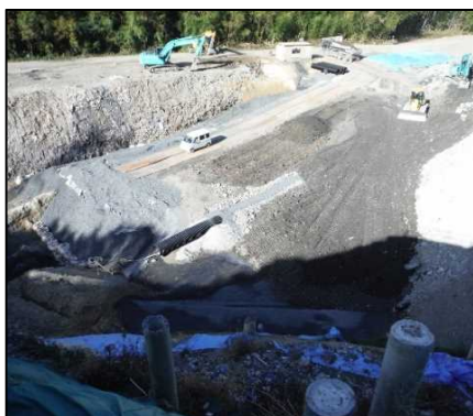
① 廃棄物掘削工 D工区の掘削を行っています。
