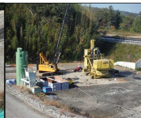
⑤ 鉛直遮水壁工 TRD機を組み立てています。
