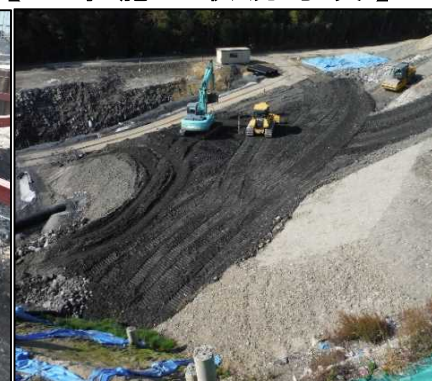
③ 選別土仮置・盛土工 D工区を埋め戻しています。
