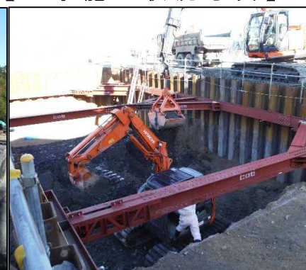
② 有害物掘削工 C-2区画の有害物を掘削しています。
