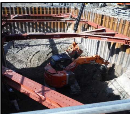
② 有害物掘削工 C区画の二次掘削を行っています。
