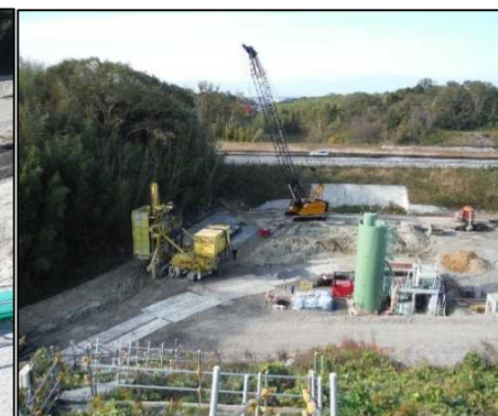
⑥ 鉛直遮水壁工 鉛直遮水壁の造成を行っています。
