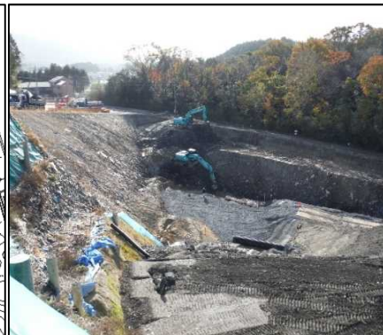
①-1 D・E工区掘削工 E工区西市道側の掘削を行っています。
