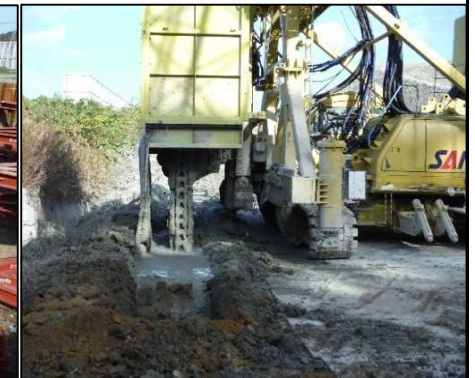
⑥ 鉛直遮水壁工 TRD機で鉛直遮水壁を造成しています。
