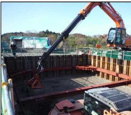
② 有害物掘削工 F区画の二次掘削を行っています。
