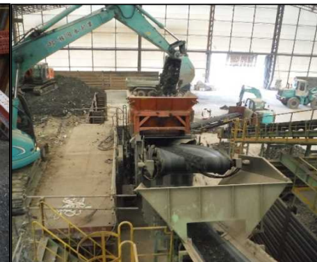
④ 選別処理工 改質の終わった廃棄物土を自走式スクリーンへ投入しています。
