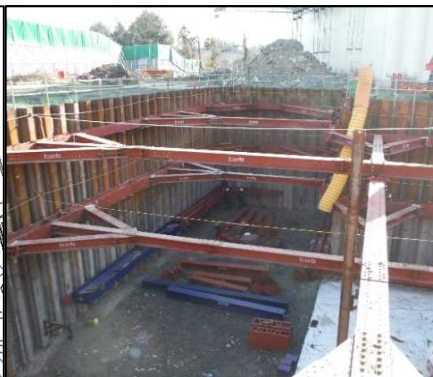
② 有害物掘削 C区画の三段目支保工を設置しています。
