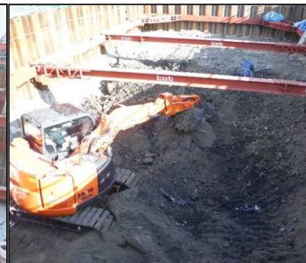
② 有害物掘削工 FG区画の二次掘削を行っています。
