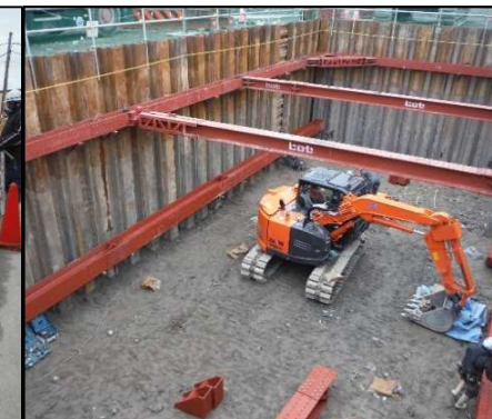
② 有害物掘削工 FG区画の二段目支保工を設置しています。
