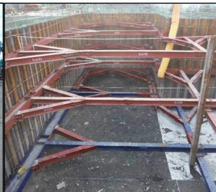
② 有害物掘削工
