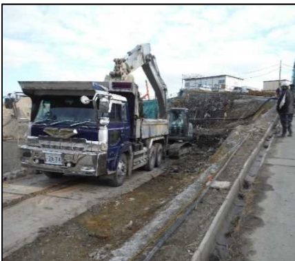
①-1 D・E工区掘削
