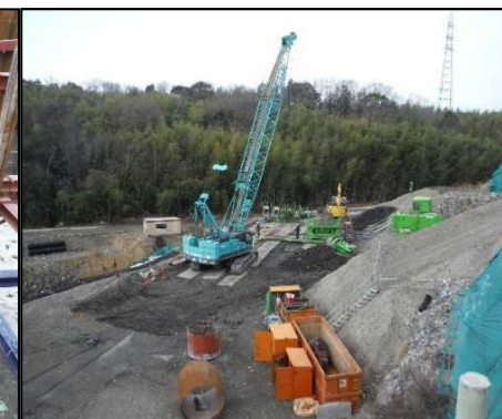
⑤ 底面・側面遮水工 全旋回オルケーシング工法にて底面遮水工を行っています。
