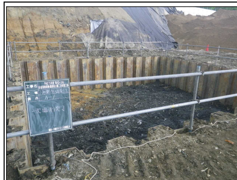
断面①：廃棄物土掘削（掘削深 約1.5m）
