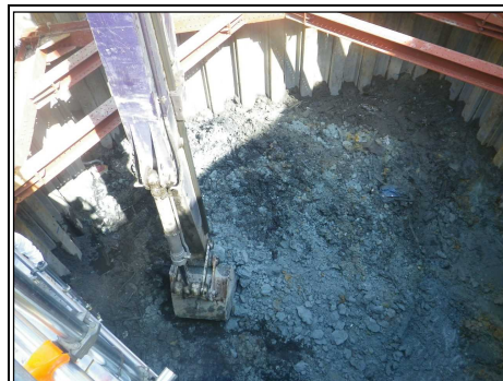
断面③：廃棄物土掘削（掘削深 約5.0m）
