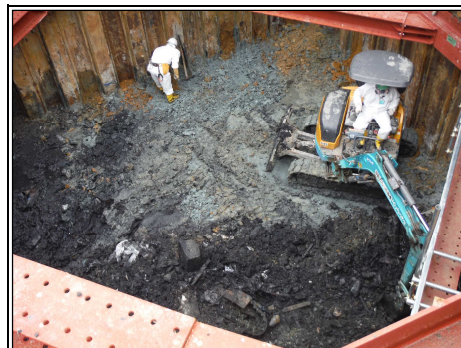
断面⑤：有害物土掘削（掘削深 約9.5m）
