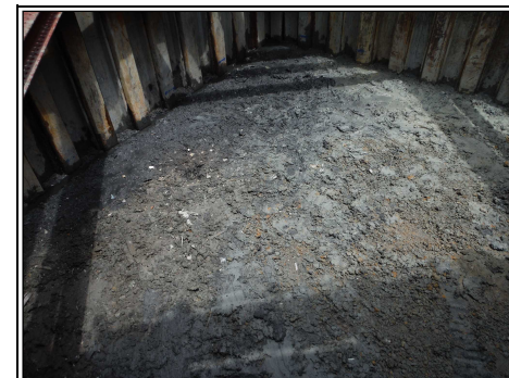
断面⑥：掘削完了（掘削深 9.9m）
