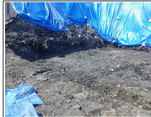
掘削完了①
