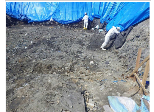
掘削完了②
