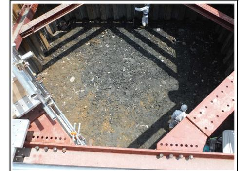
断面③：掘削完了（掘削深 約7.0m）
