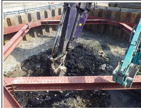
断面①：廃棄物土掘削（掘削深 約2.0m）
