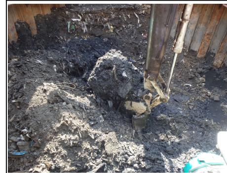
断面②：有害物土掘削（掘削深 約5.5m）
