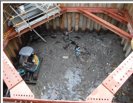
断面②：有害物土掘削（掘削深 約7.0m）
