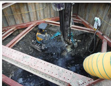
断面①：有害物土掘削（掘削深 約5.5m）
