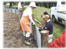
獣害防止柵の設置
