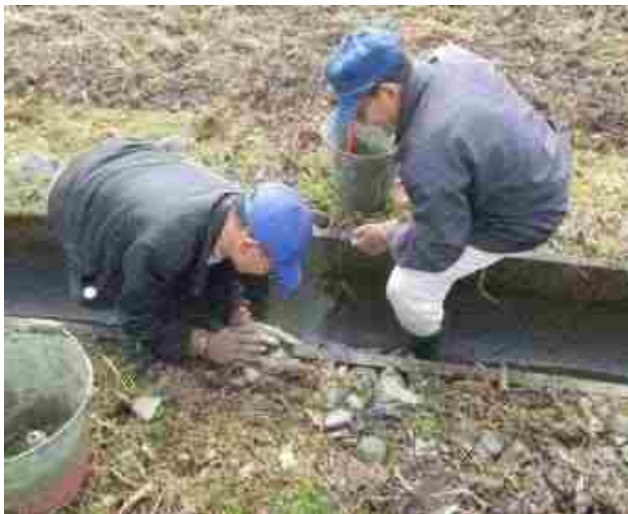
水路目地補修作業
