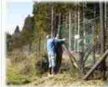
収害防止柵の補修
