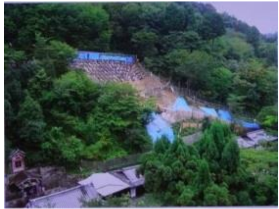
2013年の台風災害の崩壊対策工事
