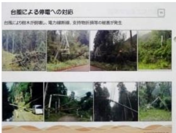
停電の原因の一つ（台風による被害）
