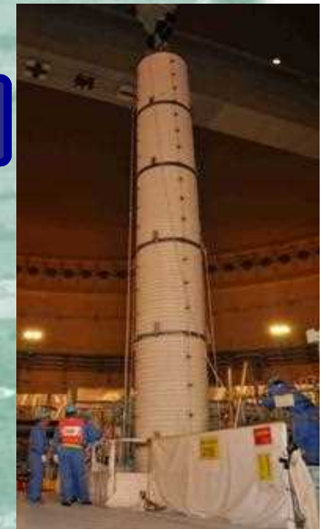
IVTM復旧作業
