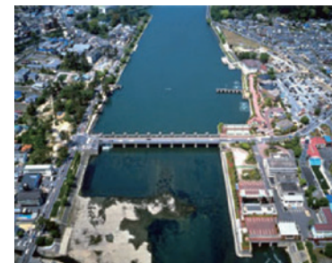
写真9-6-1 瀬田川洗堰 (琵琶湖河川事務所HP)
