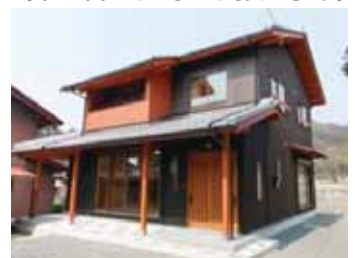
びわ湖材を使用した住宅
