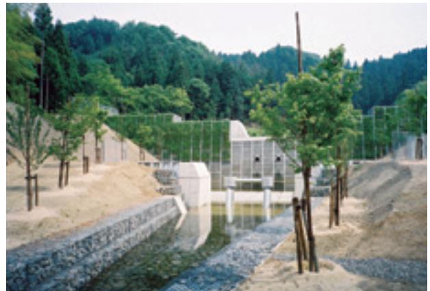
南谷砂防えん堤(米原市)
