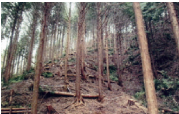
水源森林再生対策事業(甲賀市甲賀町油日)
