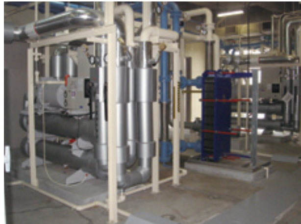
下水熱を利用した冷暖房システム
