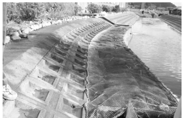
竹炭の入れ替え作業完了（近江八幡市）
