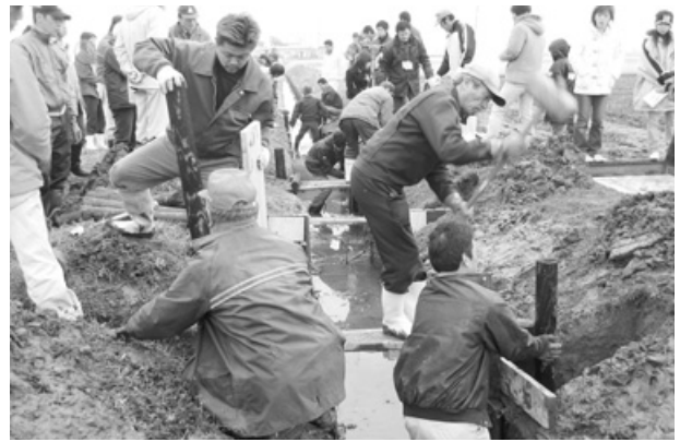
住民施工による魚のゆりかご水田プロジェクト
