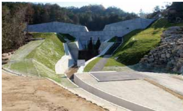
大山川支流えん堤(野洲市南郷)
