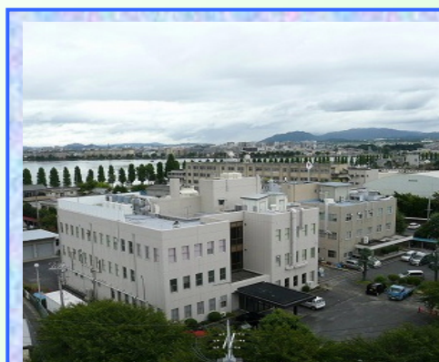
滋賀県衛生科学センター全景
