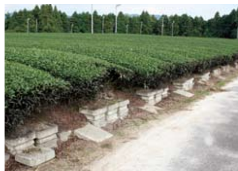
進入路段差の解消事例
