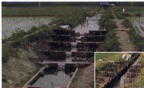
図1 近江町長沢. 枠内は堰板をはずした状態.
