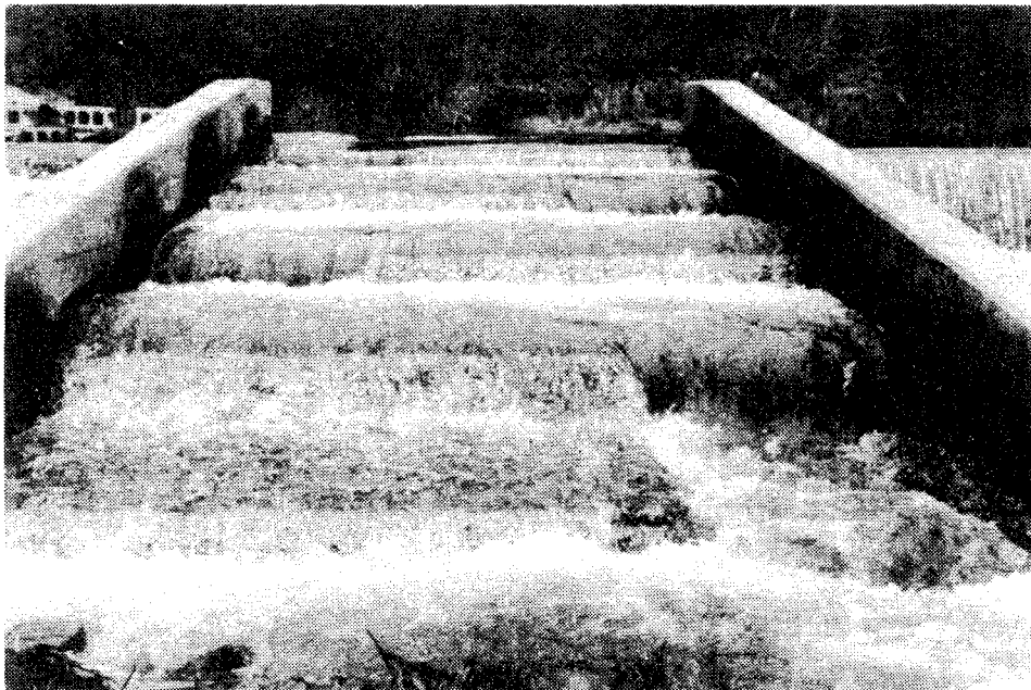
調査 2-1) 既設通路 の概況
