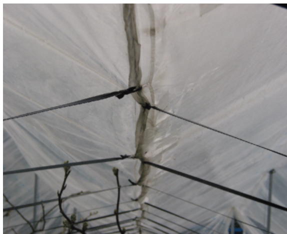
図3 フィルム間の隙間を無くした状態(2005年)
