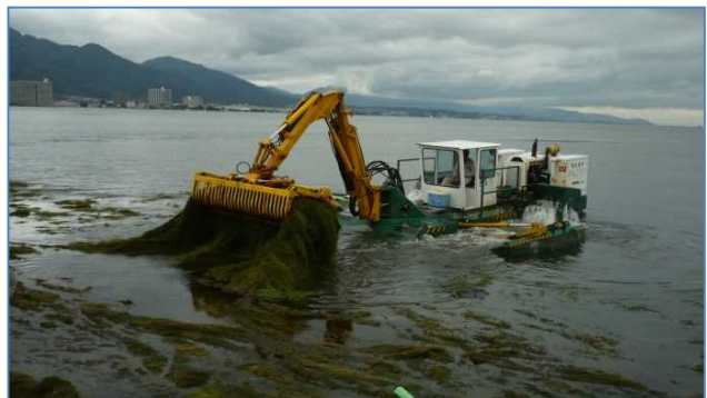
[大量繁茂した水草の除去作業(機械)]
