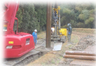
抑止杭による地すべり防止
