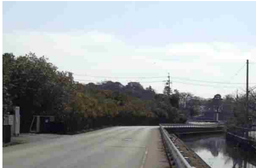
西側駐車场外周の植栽
