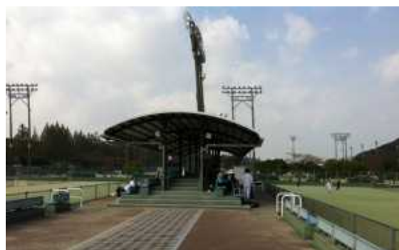
庭球場・観覧スタンド （事例 2） 出典：公園ホームページ
