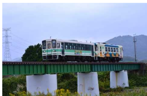
復旧した杣川橋梁（信楽高原鐵道）
