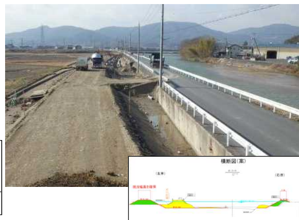
大戸川単独河川改良事業 (河道拡幅のための新堤築造中)
