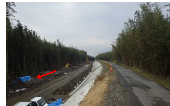
安曇川単独河川改良事業 (堤防強化:高水護岸・遮水シート工)
