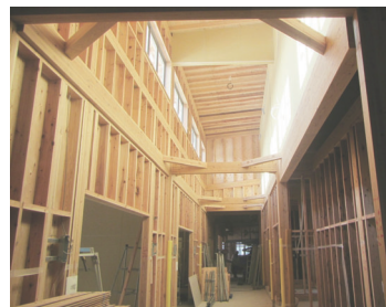
建設中のこども園。多賀町産の木材が使われています。
