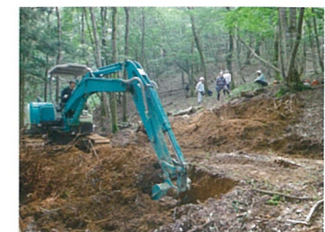
バックホーによる作業の様子
