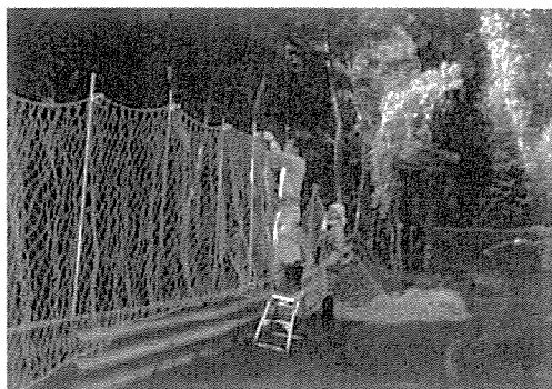
獣害防止柵の設置と補修
