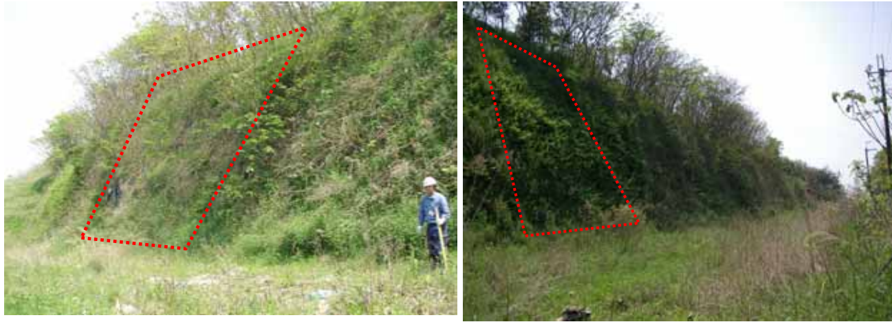
ブロック (西市道側法面:ハッホ-による掘削:2箇所)
