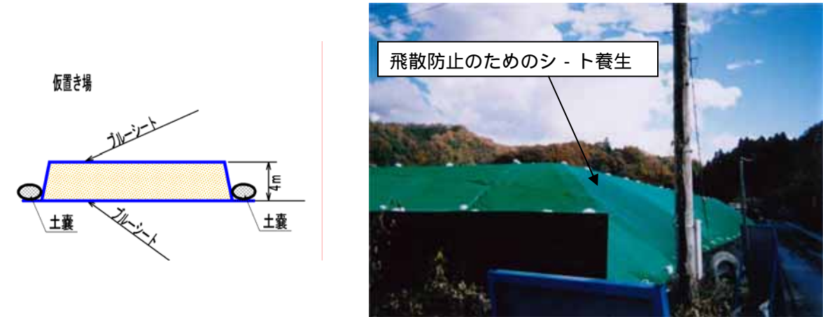
図 3.1-2 飛散防止のためのシート養生
