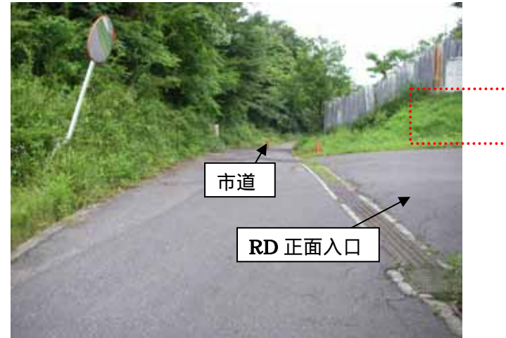
ブロック (正面入口付近:ハッホ-による掘削:1箇所)
