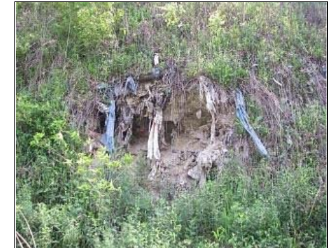
写真1.2.2 浸透水の吸い出しによる崩落
