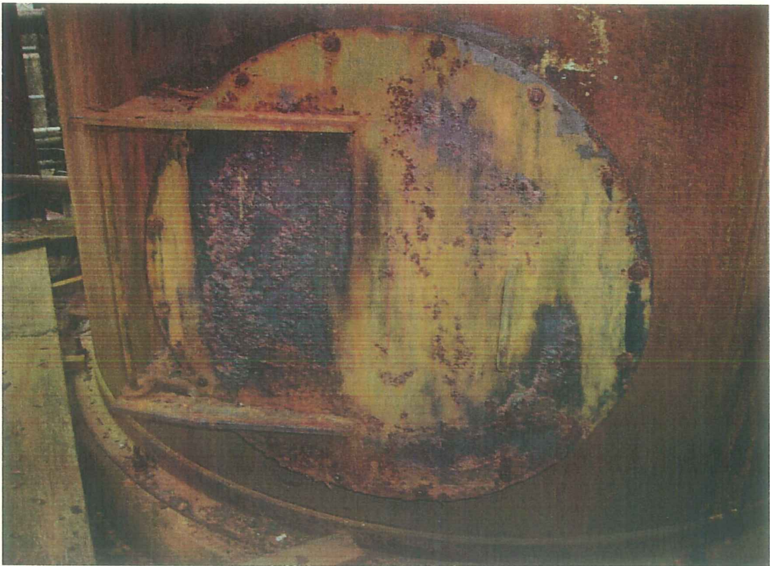
② 冷却塔点検口（拡大部）
