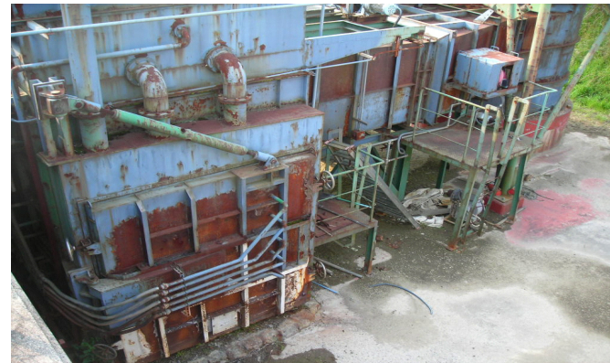
①燃烧炉下部（灰出口）
