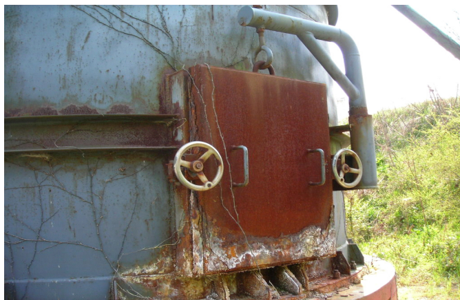
②煙突下部（点検口）
