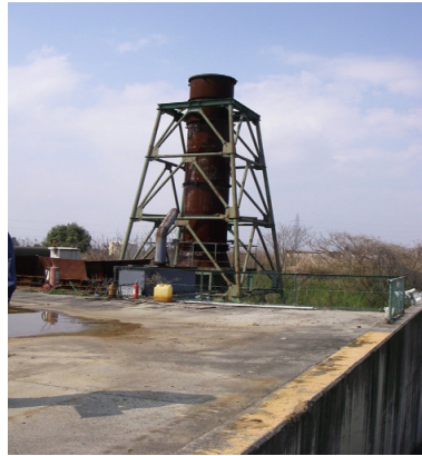
東側焼却炉全景
